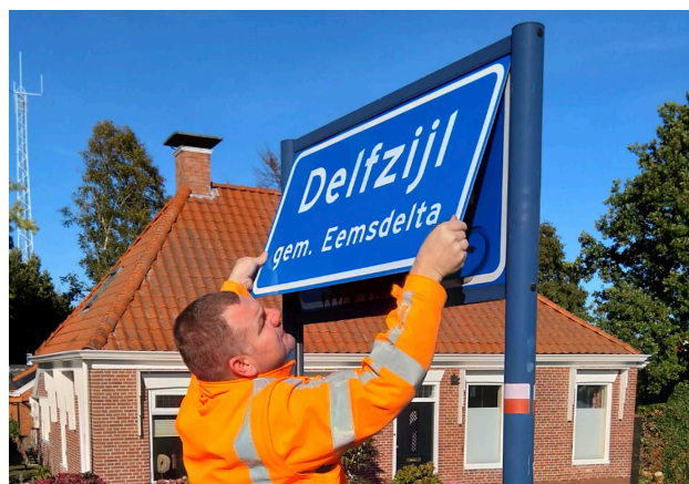
Komborden worden schoongemaakt of vervangen
